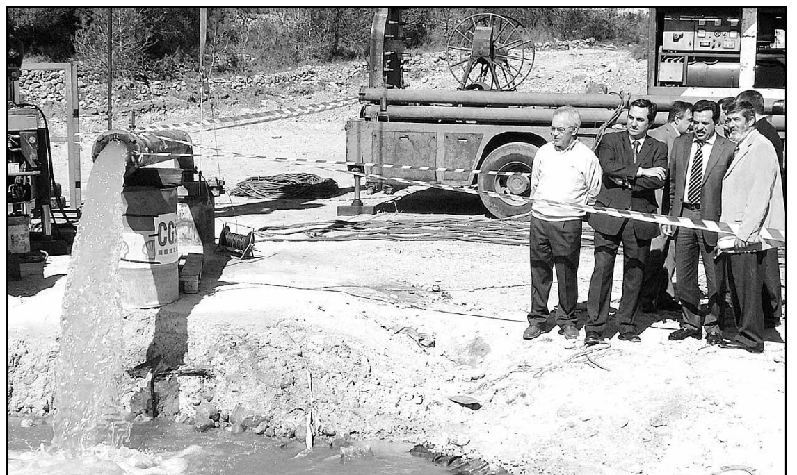
El subdelegado del Gobierno visitó las obras de aforo del sondeo de Canet lo Roig
